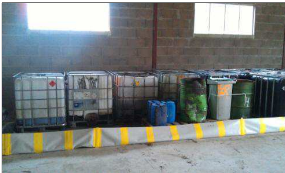
Zone de stockage rétentionnée dans le bâtiment 16
