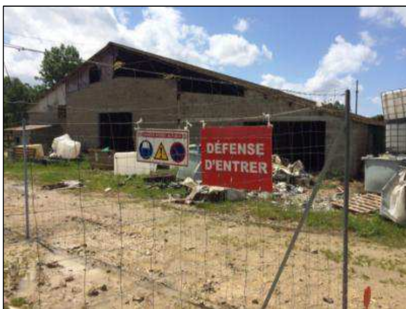
Clôture grillagée à l'est du site
