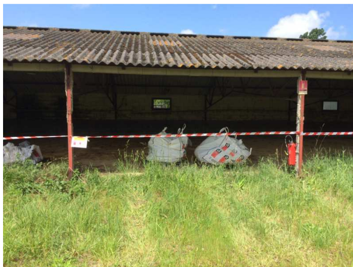
Stockage amiante – Bâtiment 17
